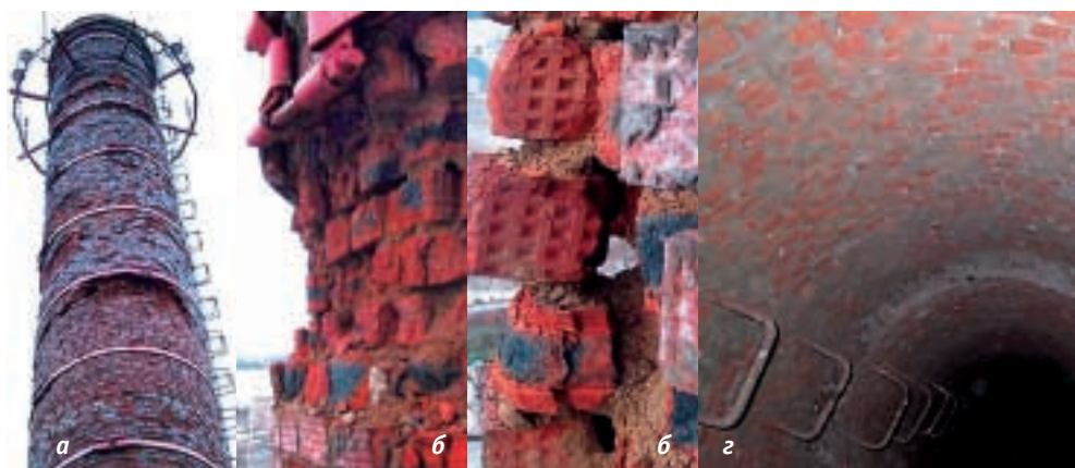
Рис. 1. Повреждения кирпичной дымовой трубы (топливо — газ) (а — эрозионные повреждения с разрушением кирпича лестницами; б — разрушение кирпича на отметке 15 м; в — разрушение раствора швов; г — внутренняя поверхность ствола трубы)
